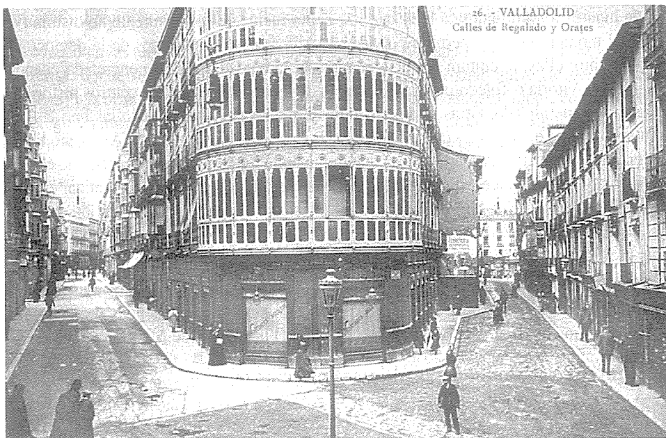
Fig. 1. Sustitución de edificios y rectificación de alineaciones en las calles próximas a la Catedral de Valladolid, durante los años entresiglos.
